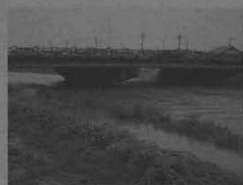
9月7日早朝の新方川 台風9号による増水
